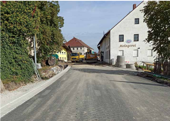
Asphalt-Tragschicht Hauptstraße
