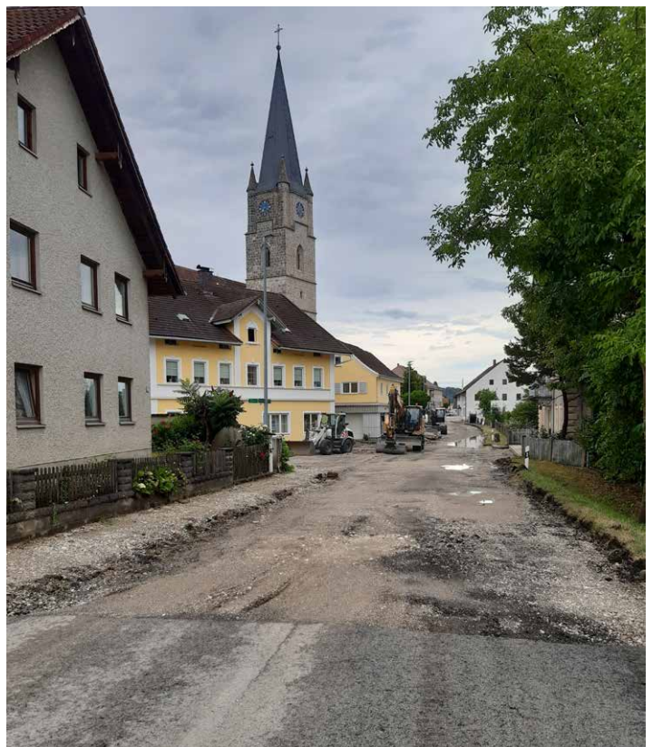
Ausbau Asphaltdecke
