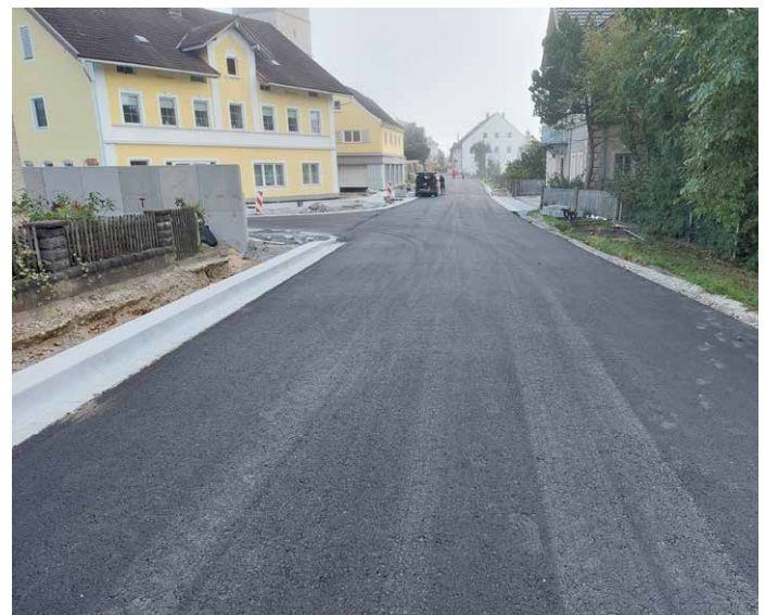
Asphalt-Tragschicht Hauptstraße
