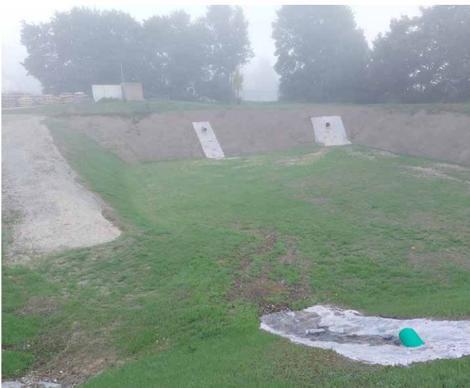
Fertigstellung Sickerbecken für Straßenentwässerung
