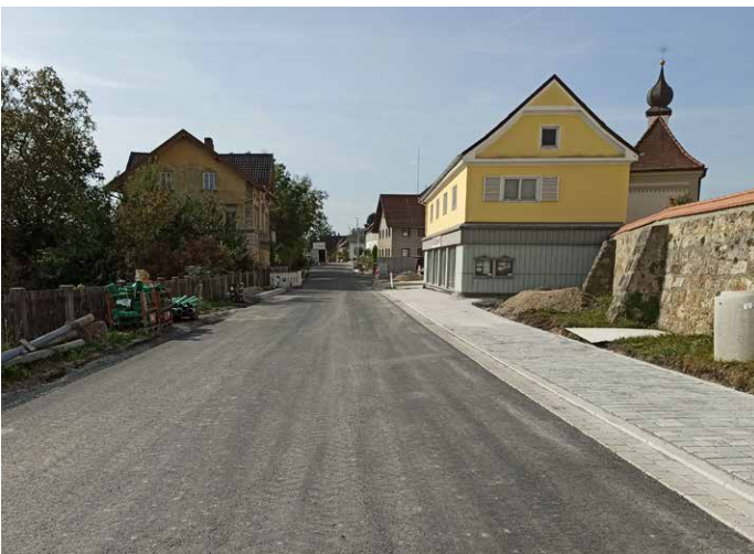
Asphalt-Tragschicht Hauptstraße und Pflaster Gehweg
