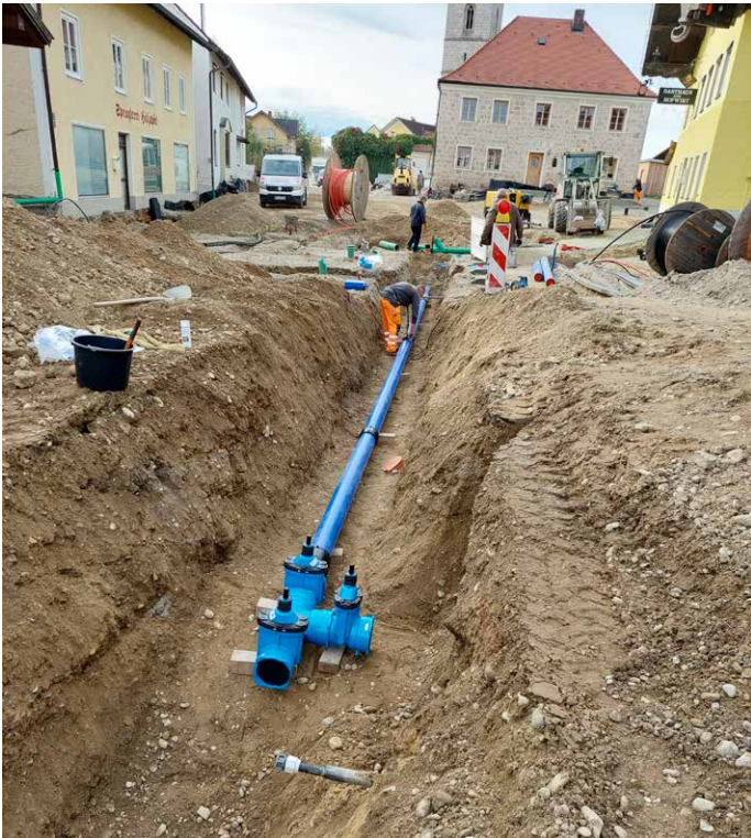
Verlegung der neuen Wasserleitung
