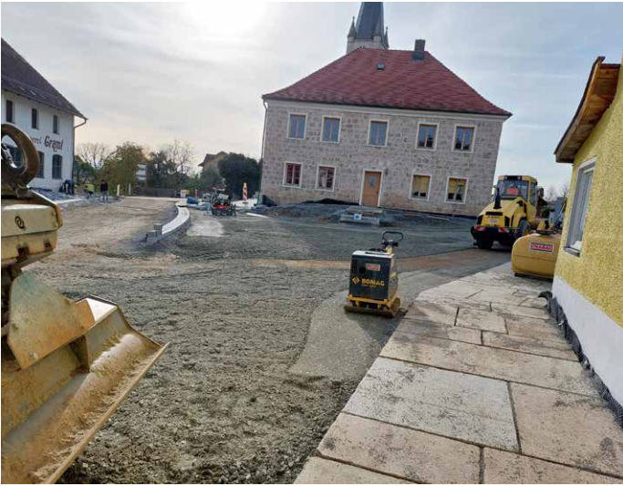
Verlegung Gredplatten Höhe Hofwirt
