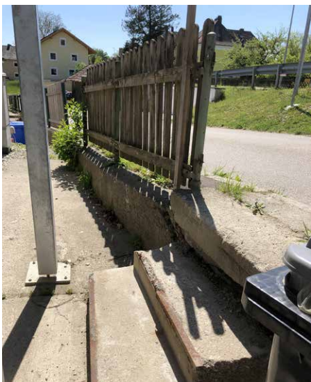
Stützmauer vor Baubeginn
