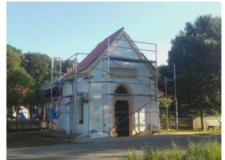
Aufgrund der maroden Dacheindeckung wurde die Hofbauerkapelle saniert. Nach erfolgter Einholung von Kostenangeboten erhielt die Firma Holzbau Lorenz aus Biberg den Zuschlag. Bei der Sanierung wurde die gesamte Unterkonstruktion (Dachschalung, Dachbahn u. Lattung) des Daches erneuert bzw. ergänzt, das Dach wurde neu eingedeckt, der alte Dachstuhl konnte erhalten bleiben.
