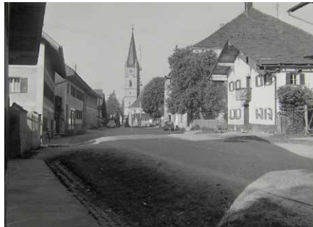
Pflasterstraße durch Malching 1959
