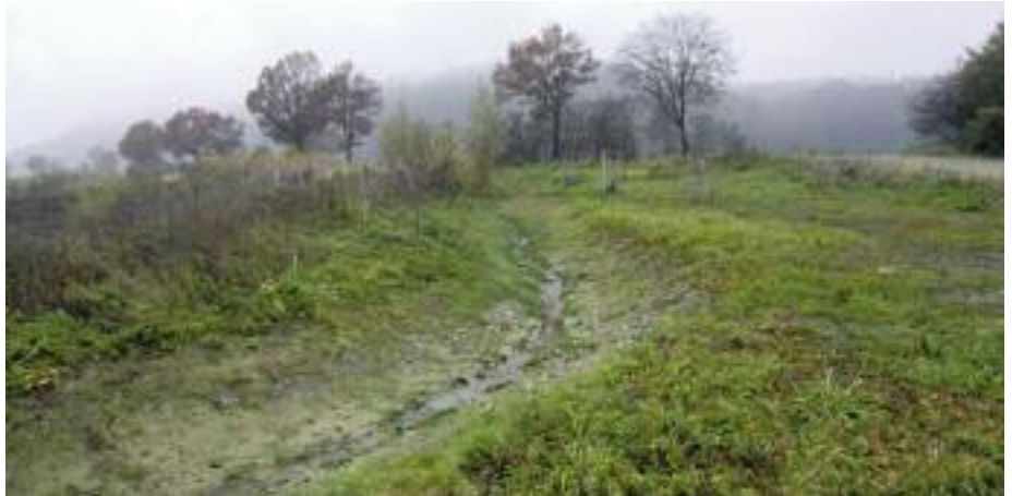
Fertiggestellter Zulauf von der alten B12 zum Schlammbecken.
